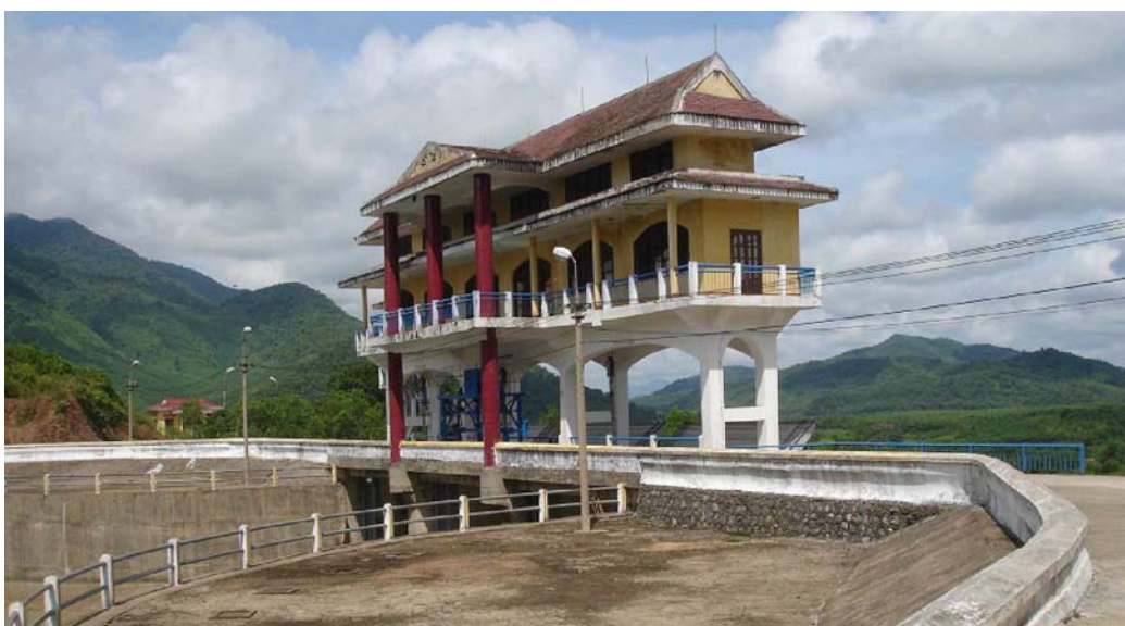
Nhà quản lý vận hành tràn
