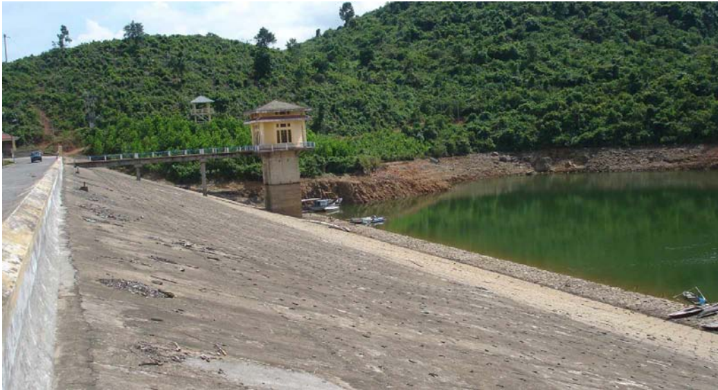
Mái thượng lưu đập
