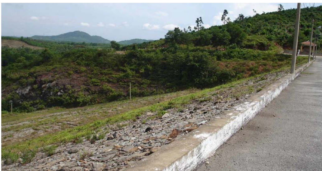
Đỉnh đập và phần trên mái hạ lưu
